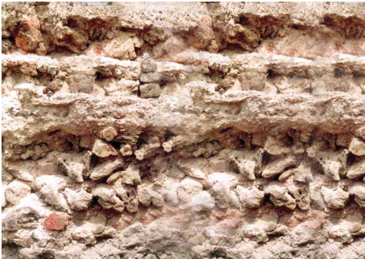
Secuencia de rellenos de tezontle y argamasa de cal, arena y tezontle molido que sirvieron como base de los diferentes niveles de pisos de los patios aledaños al Templo Mayor (foto R. Barrera).
