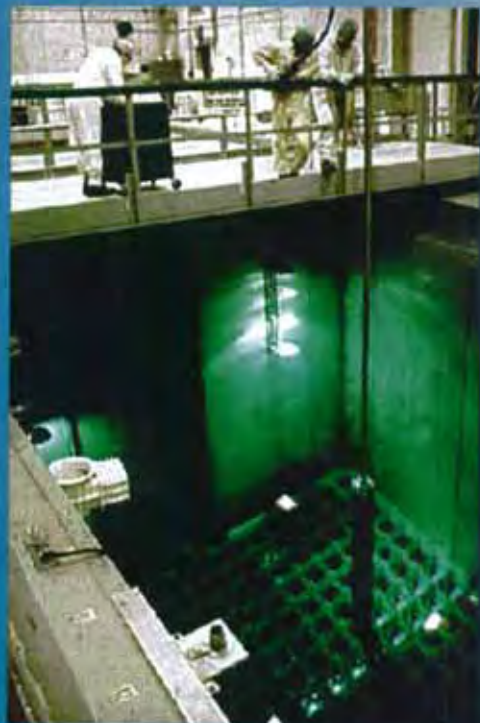
Figura 4. Interior de un reactor nuclear se encuentra en una piscina que contiene agua pesada. Aquí también se produce un subproducto de alta energía.
