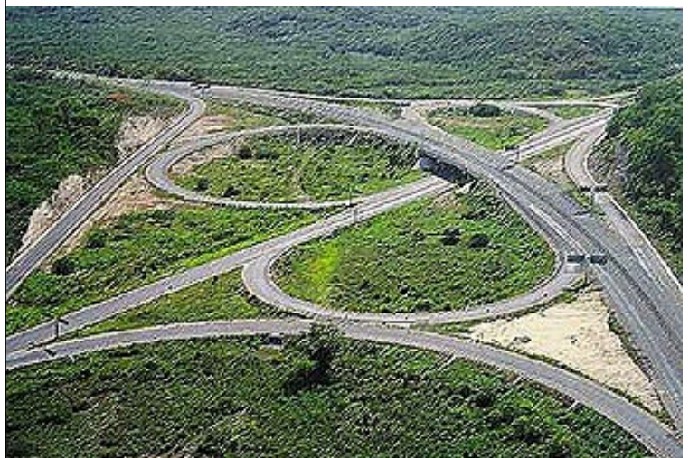
Figura 3. Cruce vehicular en la carretera Ciudad del Carmen-Campeche-Mérida
