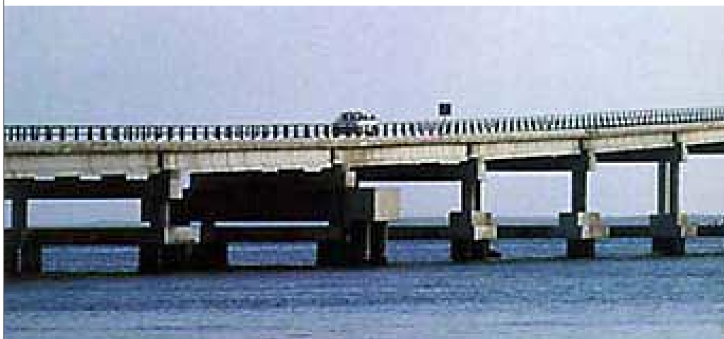
Figura 5. Puente de concreto reforzado Carmen-Zacatal.
