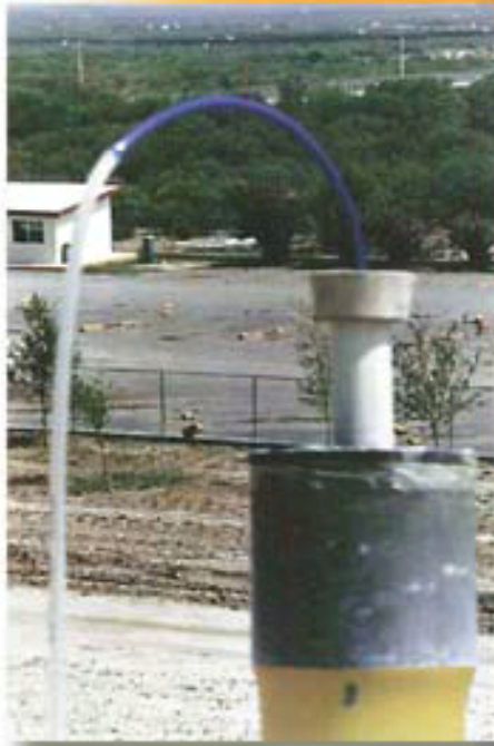
Figura 2. Recolector de biogás instalado en Nuevo Laredo.
