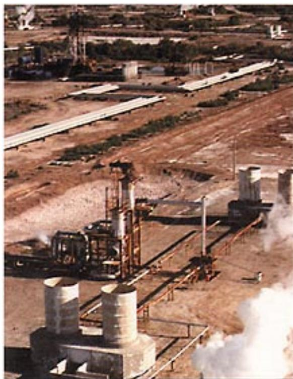
Silenciador instalado sobre un pozo geotérmico en la planta geotermoelectrónica de Cerro Prieto.
