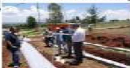
Instalación de la tubería de salida de biogás
