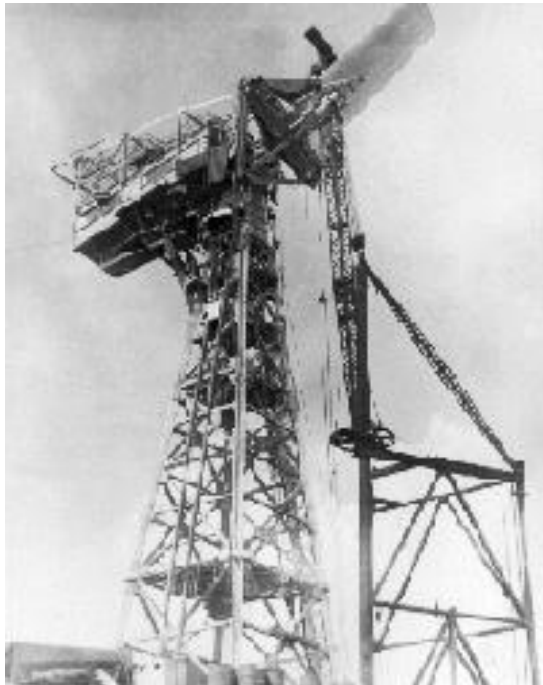
Durante la construcción
