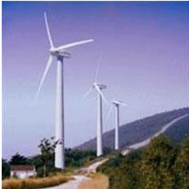
Parque eólico comercial.
