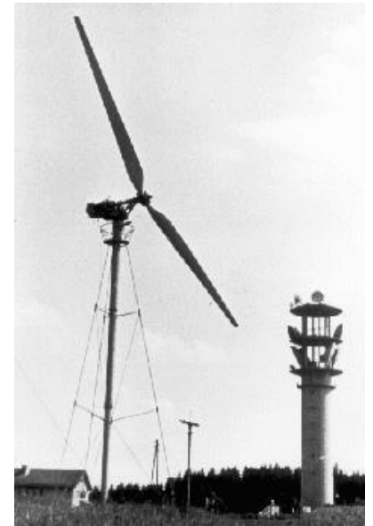
La turbina Hütter-Allgaier (diám. 34m, 100kW) Alemania 1973. Contaba ya con muchos elementos tecnológicos usados comercialmente hoy en día.
