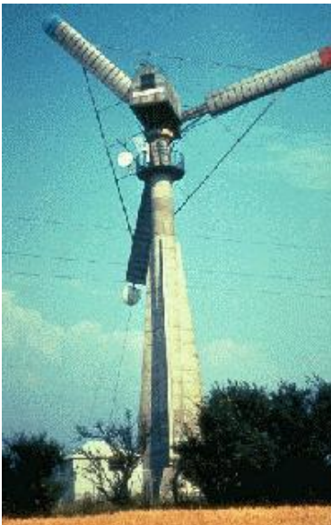
La turbina Gedser (diám. 34m, 200kW) Dinamarca 1956. Remozada en 1977. Nótese los refuerzos mecánicos.
